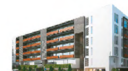
Edificio Vemiá Surco
