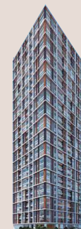
EDIFICIO ALL San Isidro
