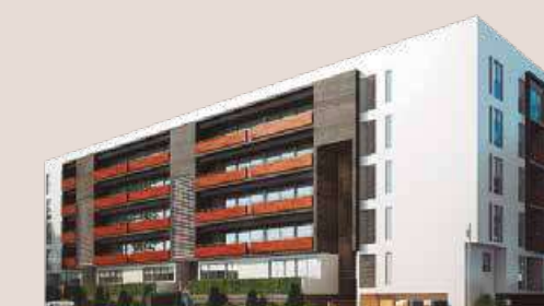
EDIFICIO VEMIÁ Surco
